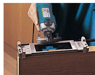
Colocación en la puerta (Mod. A093)
