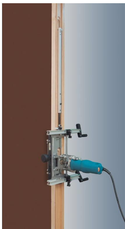
Realización del segundo encaje en el marco.
