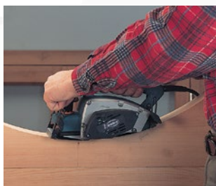
Cepillado de superficies cóncavas.
