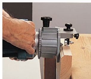
Realización de molduras.
